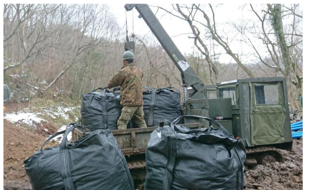
むつみ演習場にて 崩落箇所の整備
