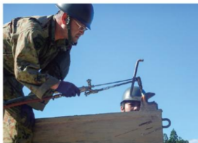
10月 直支隊 教育訓練基盤構築ガス溶接作業の様子
