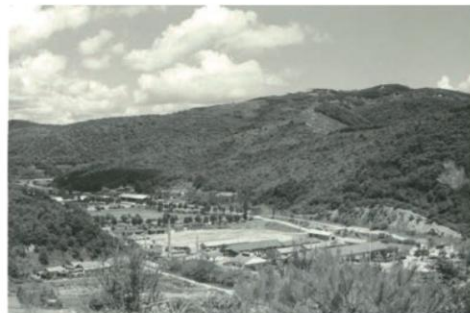
昭和38年8月に撮影された駐屯地内
