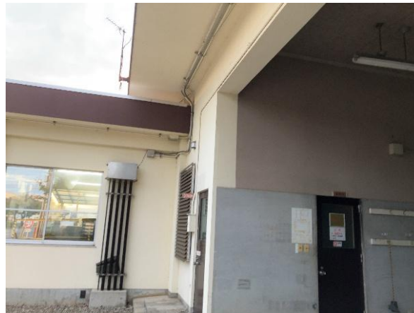
配管敷設場所
