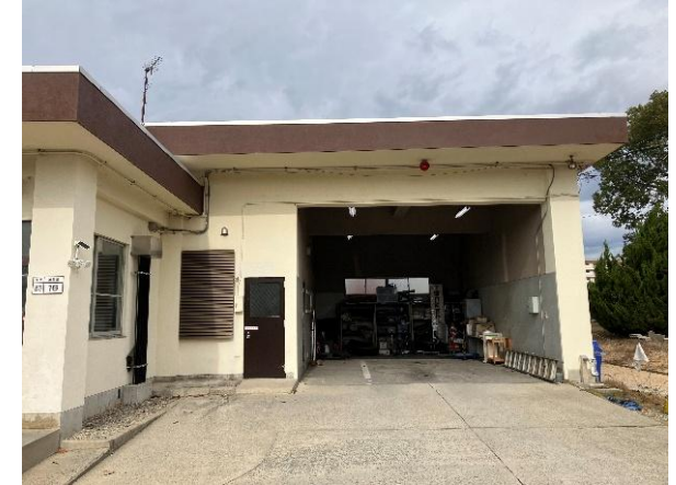
配管敷設場所
