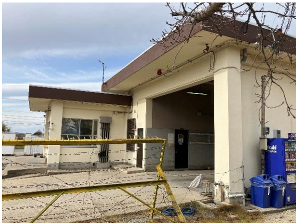
配管敷設場所
