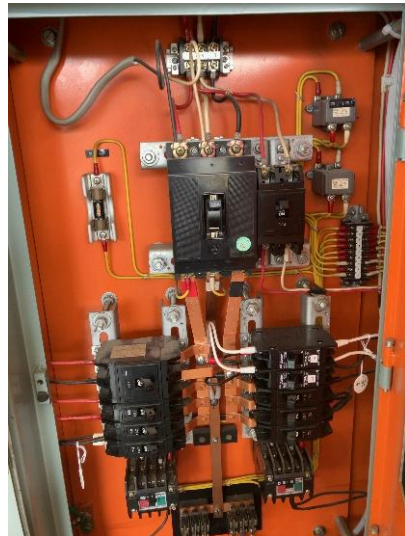
既設分電盤盤内上部
