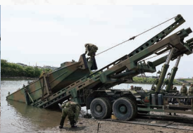
浮橋架設訓練
