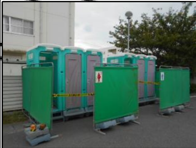
仮設トイレ設置 ※イメージ
