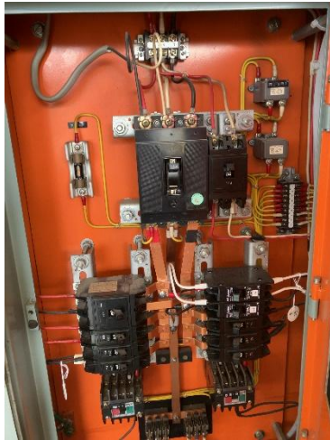
既設分電盤盤内上部
