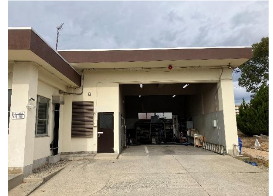
配管敷設場所
