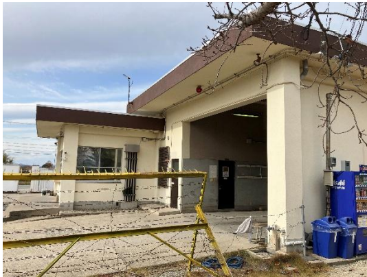
配管敷設場所
