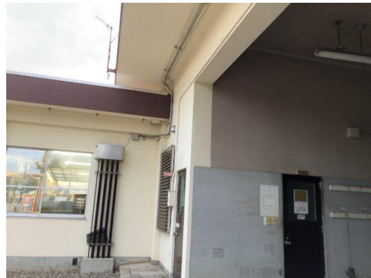
配管敷設場所
