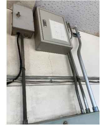
既設分電盤盤上部
