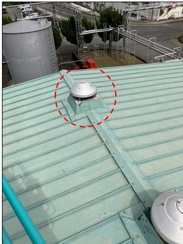
高所作業車より撮影
