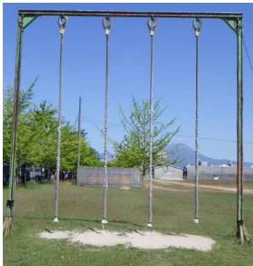
既設鉄骨レール全体写真
