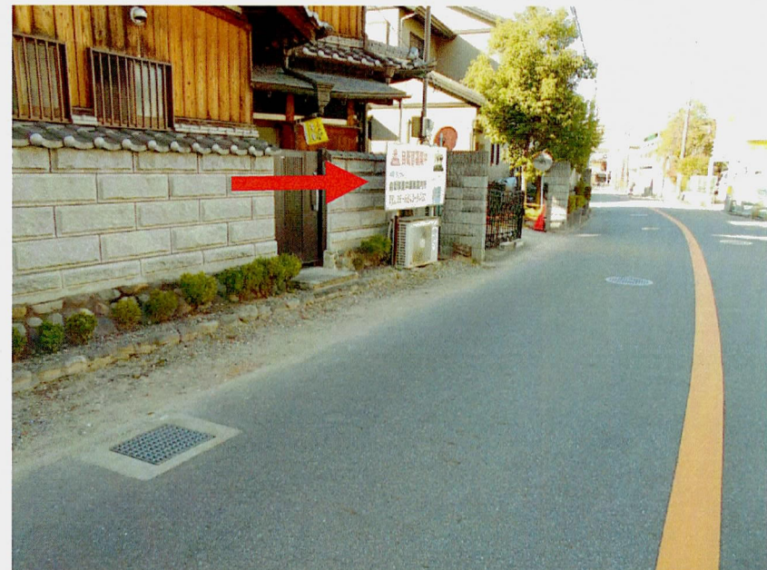
全体的な設置状況の分かる写真
