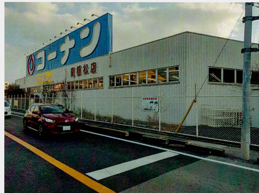
全体的な設置状況の分かる写真
