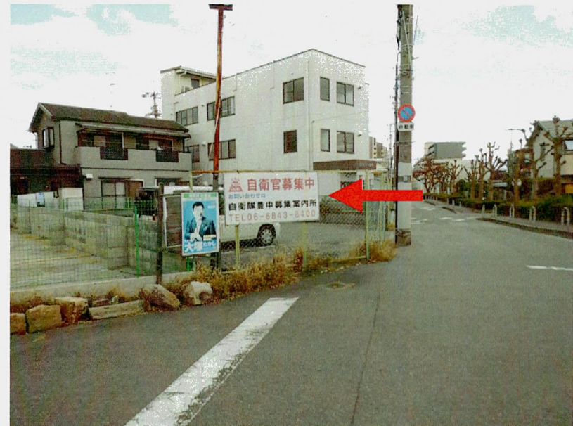
全体的な設置状況の分かる写真
