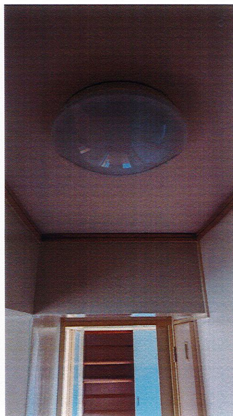
玄関廊下天井
