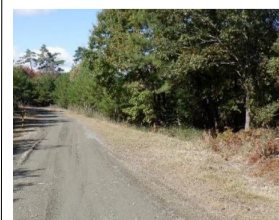
整備後の幹線道路
