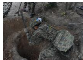
L AM用掩体構築
