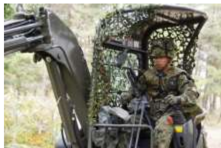
第2次中隊等訓練検閲 [掩体を構築する施設作業小隊]
