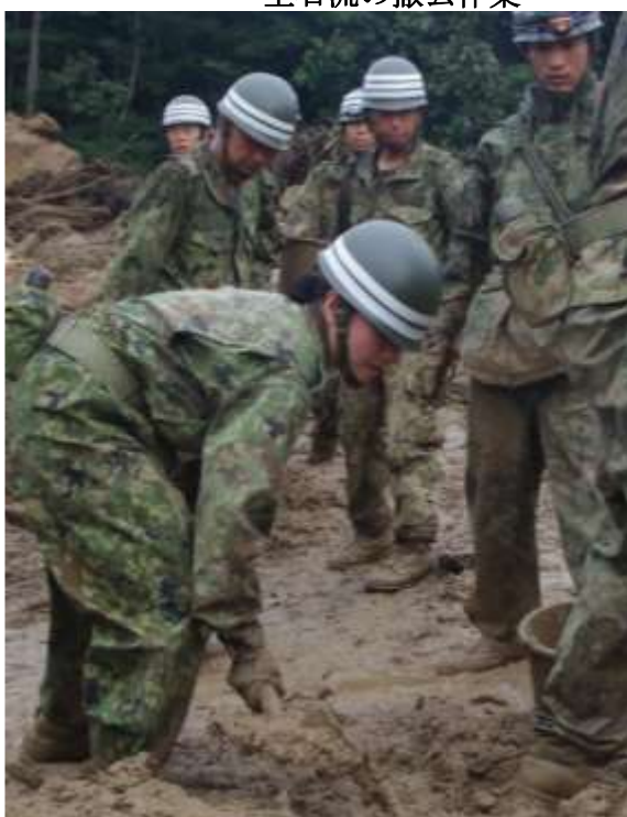
たまった土石の除去
