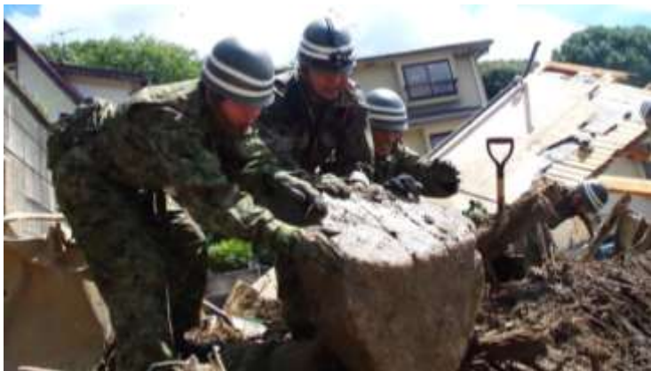
土石流の撤去作業
