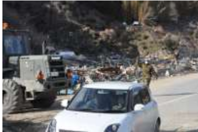
重機による道路啓開
