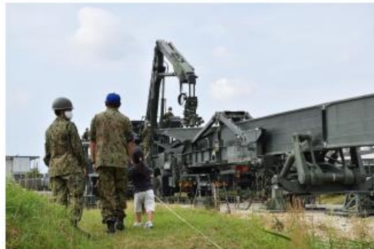
第13施設隊による架柱車の説明
