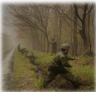
側溝清掃①
