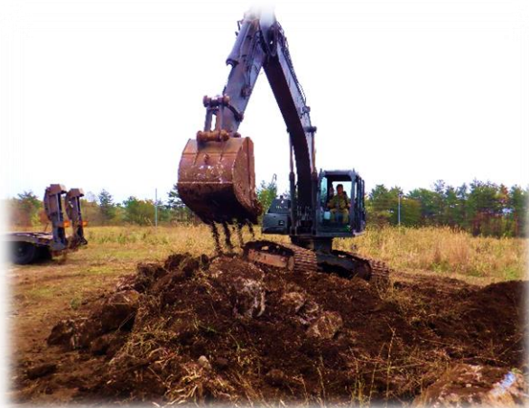
油圧ショベルによる作業
