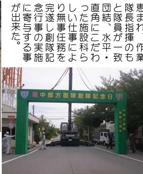
クレーンによるアーチの設置 ▶
