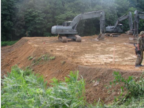
▶ 訓練施設の改修作業
