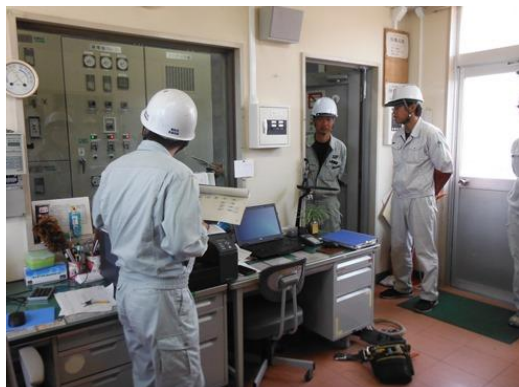
▲ 非常用電源の稼働
