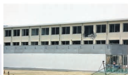
◀旧隊舎 ▼完成した新庁舎外観
