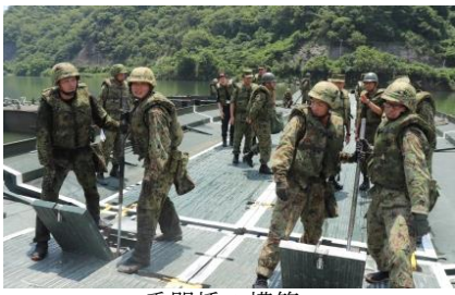
重門橋の構築
