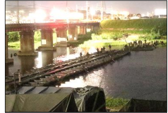
軽浮橋の構築
