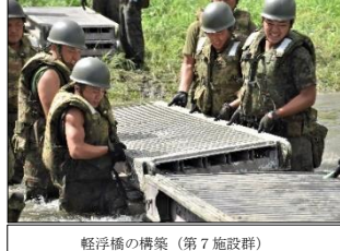
軽浮橋の構築(第7施設群)
