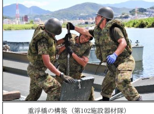
重浮橋の構築(第102施設器材隊)
