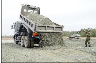
碎石の敷き均し
