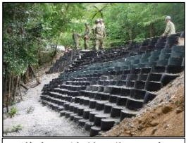
道路の肩部法面復旧工事
