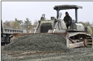
湿地ドーザによる敷き均し
