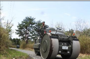
ロードローラーによる道路転圧
