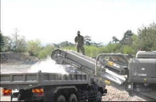
ガラバゴスによる碎石・積載
