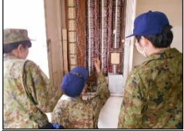
端子盤への接続
