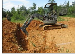
指揮所構築のための掘削
