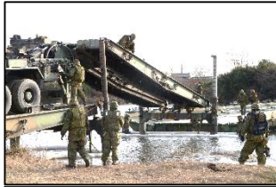
混合橋の構築
