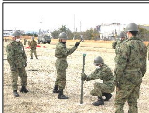
施設基礎作業(杭の打ち込み)
