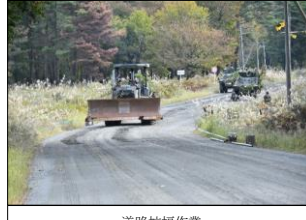
道路拡幅作業
