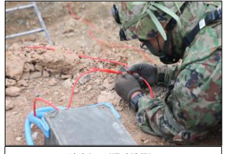
障害処理(爆破準備)
