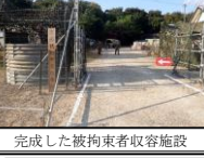
完成した被拘束者収容施設
