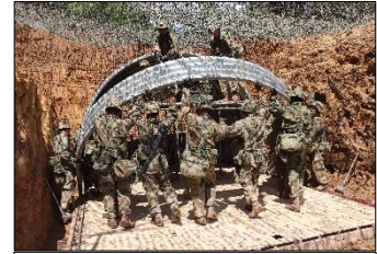
指揮所用軽掩蓋掩壕の構築
