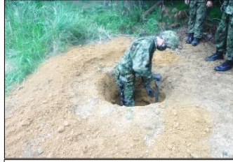
退避壕の掘削
