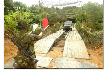
橋梁(自走架柱橋)の通過
