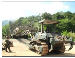
パネル橋MG Bの構築
