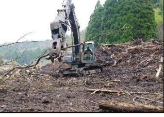
伐採木の処理
