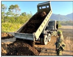
ダンプによる土砂の敷き均し
