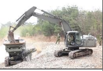
日本原演習場春季整備(砕石の状況)
