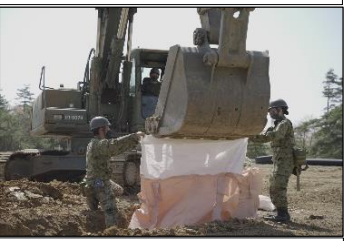
標的設置位置の新設
