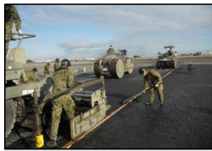
レーキによる敷き均し
