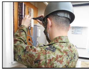
端子盤の点検・接続
