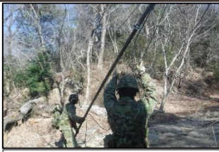
アンテナ建柱
