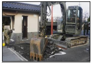
既存アスファルト除去
