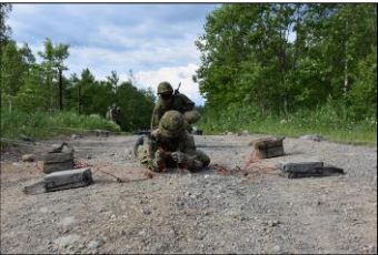
集団装薬を使用した障害処理
