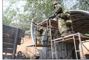
指揮所用簡易掩蓋掩壕の本体部構築
