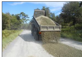
走行ダンプによる碎石の卸下作業
