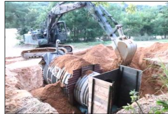
機関銃用簡易掩蓋掩壕の埋め戻し
