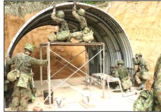
指揮所用簡易掩蓋掩壕の本体部構築
