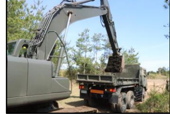
幹線・支線道路整備における置換(運土)作業
