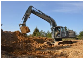
油圧ショベルによる対戦車壕構築
