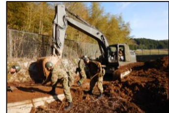
油圧ショベルを用いた沈砂池排砂作業
