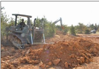
ドーザによる対戦車壕構築
