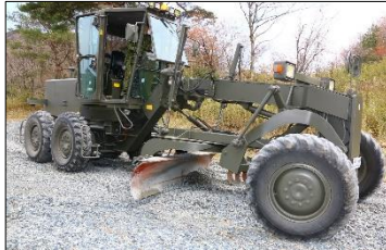
グレーダーによる幹線道路整備
