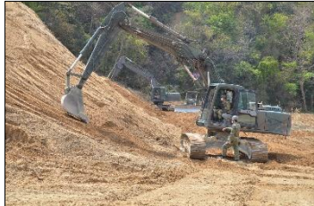
油圧ショベルによる法面成形
