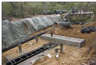
砂防堤建設工事
