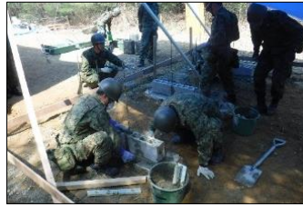
新爆破訓練場付帯設備補修整備
