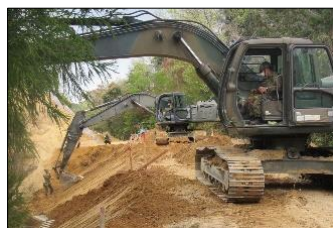
南中道拡幅工事
