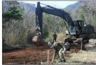
TK射座取付道整備
