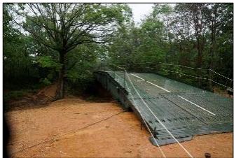
07式機動支援橋の架設
