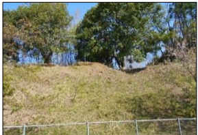
官舎地区外柵沿い (作業後)
