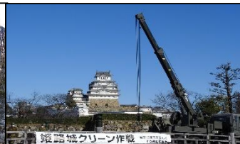
除草した雑草等の搬出作業中の重トラック
