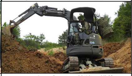
小型ドーザによる掩体の構築
