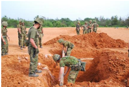
2次掘開後、掩蓋材を乗せる
