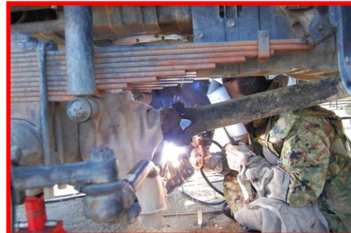
巧みの技が光る溶接作業
