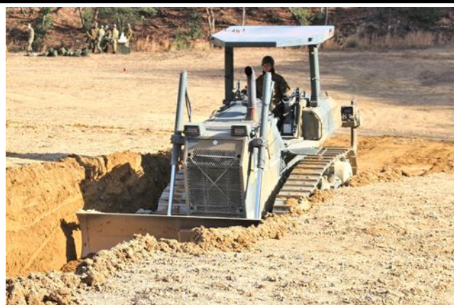
ドーザによる掘削
