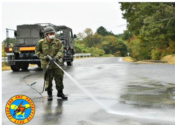
道路上の泥の除去（第3特殊武器防護隊）
