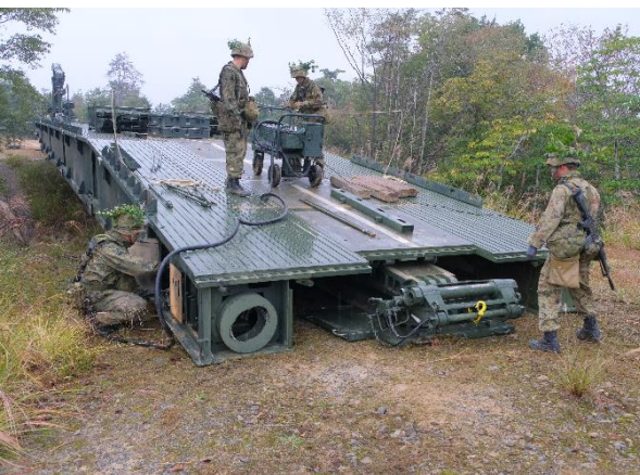
O 7 式機動支援橋の架設
