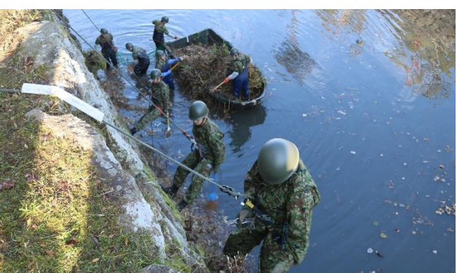
城壁等の草木除去
