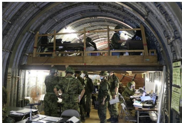
防衛準備間における演習師団司令部指揮所掩体構築の概成（第3施設大隊）
