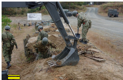
L AM射座改修前
