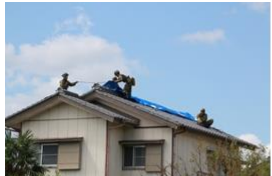
破損家屋へブルーシートを展張 (鴨川市 第2支援中隊)
