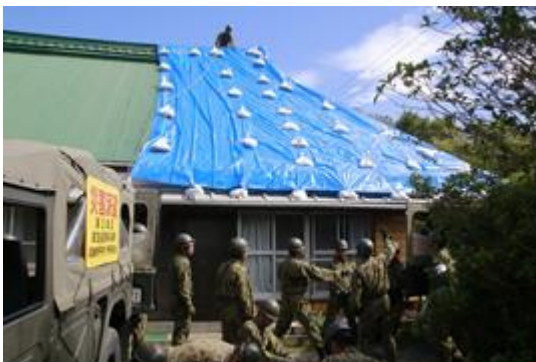
破損家屋へブルーシートを展張 (鋸南町 第1支援中隊)
