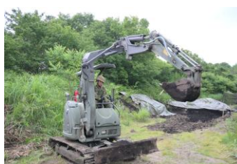
重機を使用した築城
