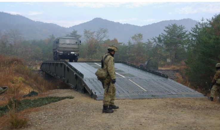
ビーム架設後、橋節を構成し車両による 通過点検の様子
