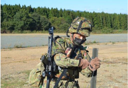
U字杭及び有刺鉄線によるヘリボン障害の構成
