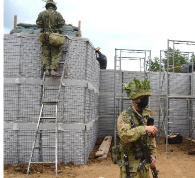
近SAM用ソイルアーマーの掩蓋俺壕構築(本人:写真右)
