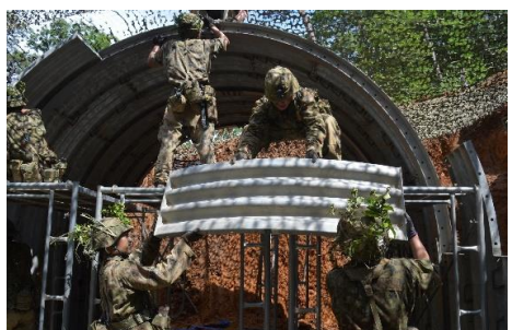
ライナープレートを運搬する第2施設小隊
