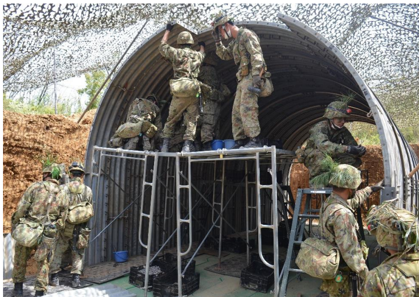
ライナープレートを使用し本体部を構築する 第1施設小隊隊員
