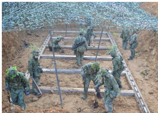
枕材及び間隔材を設置する 第2施設小隊隊員
