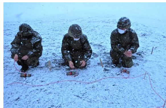
装薬回路の構成（基礎爆破）
